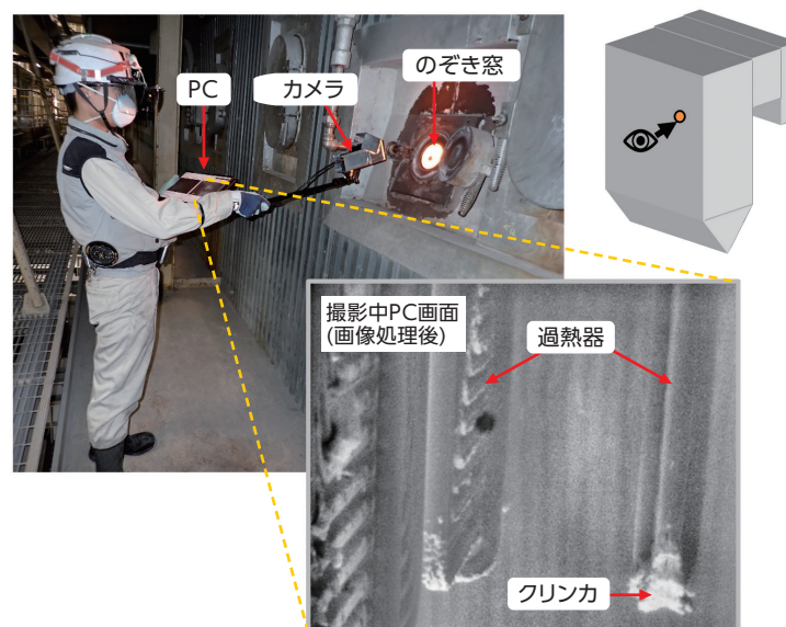
C-BISを用いた運転中の石炭火力ボイラ内部の観察
