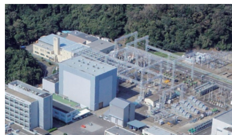
大電力試験所 全景
