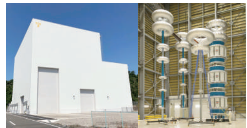
超高压級CVケーブル絶縁特性実験棟 外観と設備
