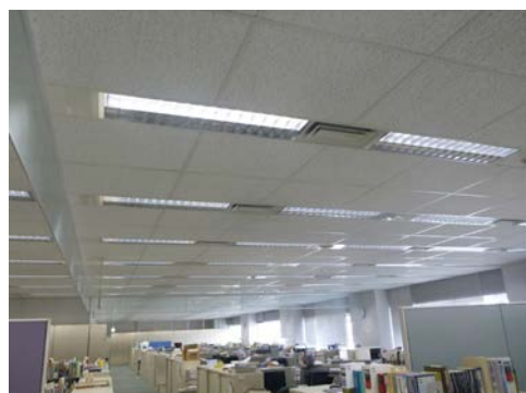
LED照明に更新した居室
