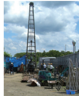
ボーリング調査
