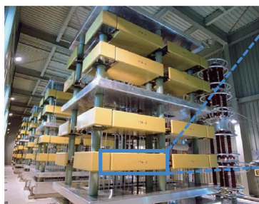
■ 周波数変換所の交流/直流変換器の例（サイリスタバルブ）※1
