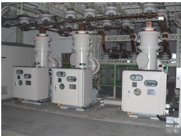
写真1 投入開閉器（3相分）の外観
