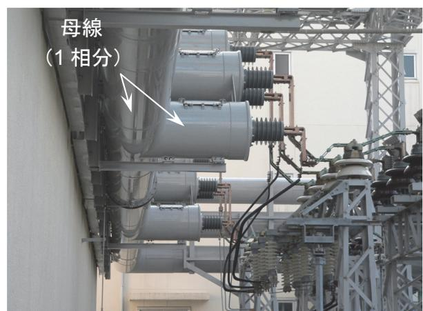
写真2 発電機相分離母線の外観
