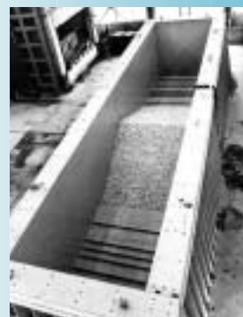
大規模フィルダムの耐震安定性などの 振動台実験 (S45年ごろ～)
