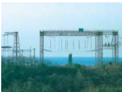
500kV課電ばく露実験場 (S46年)
