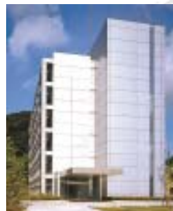
横須賀研究所本館が竣工（H8年）
