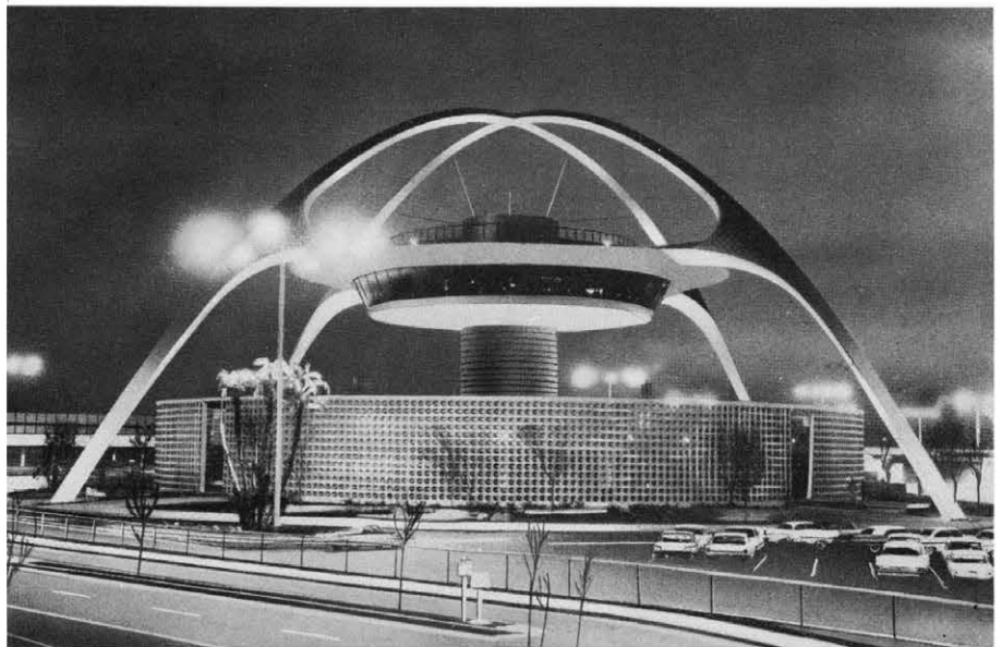
ロスアンゼルス空港 テーマビル
