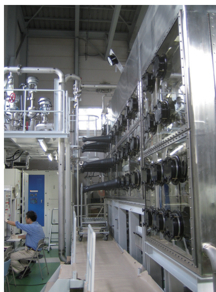
図2 大型Ar雰囲気グローブボックス
