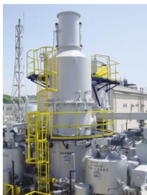
図1 バイオマス/廃棄物ガス化炉
