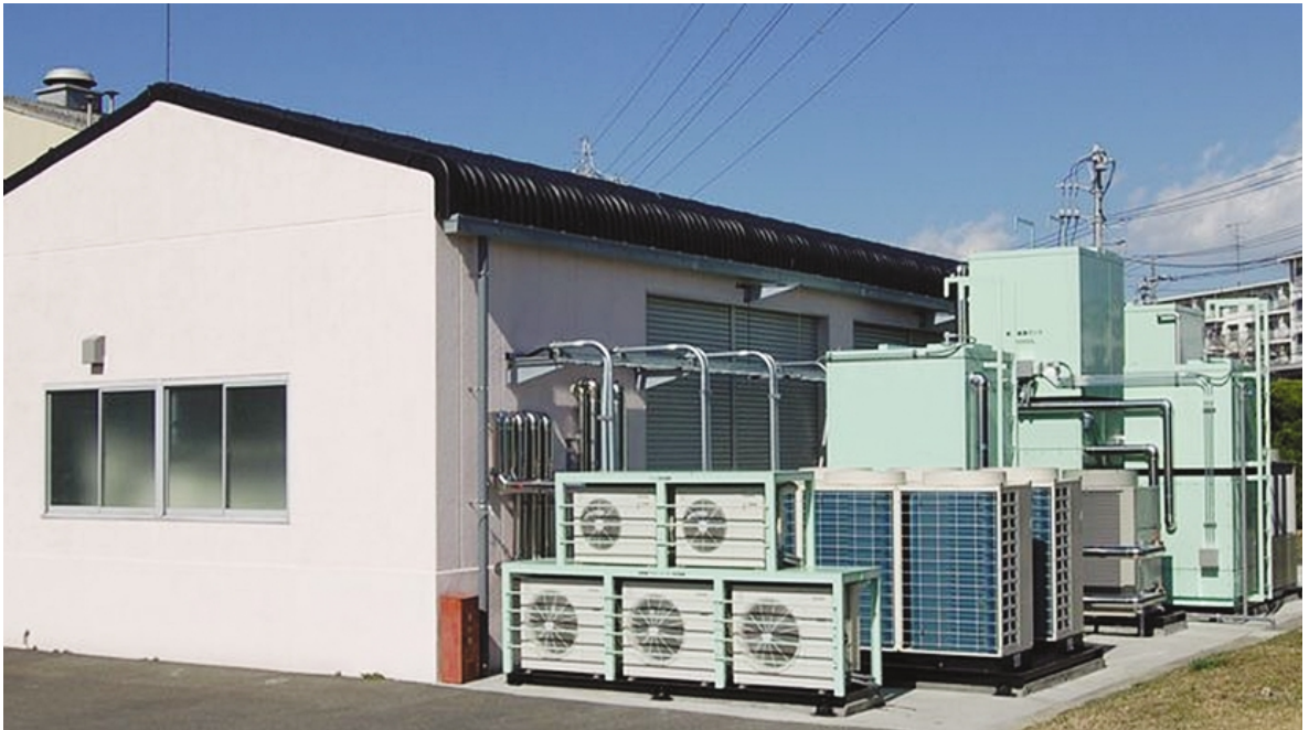
エコキュート性能評価試験設備（試験棟外観と建屋外側設置機器）
