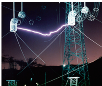
送電線の雷実験
