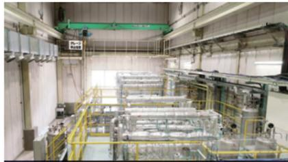
**火力給水処理試験設備**
