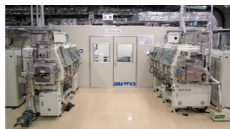
二次電池評価試験設備
