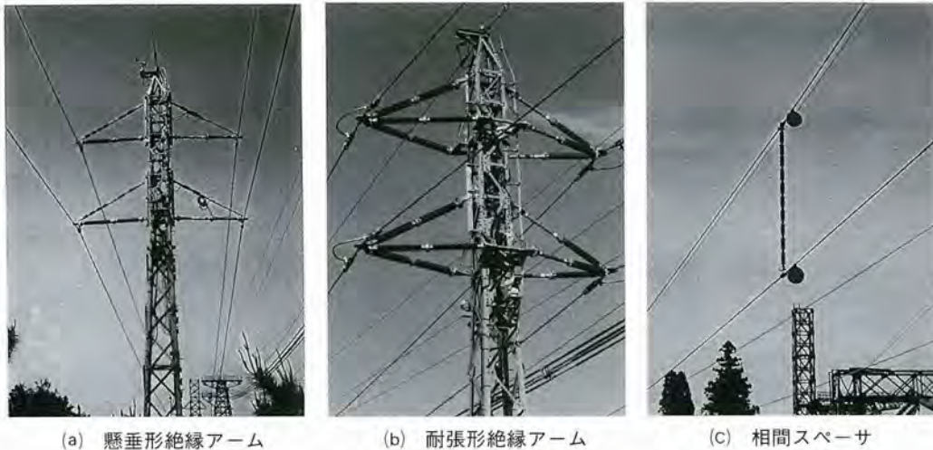
図2-3-2 154kV高分子絶縁アームおよび相間スペーサの取付け状況
