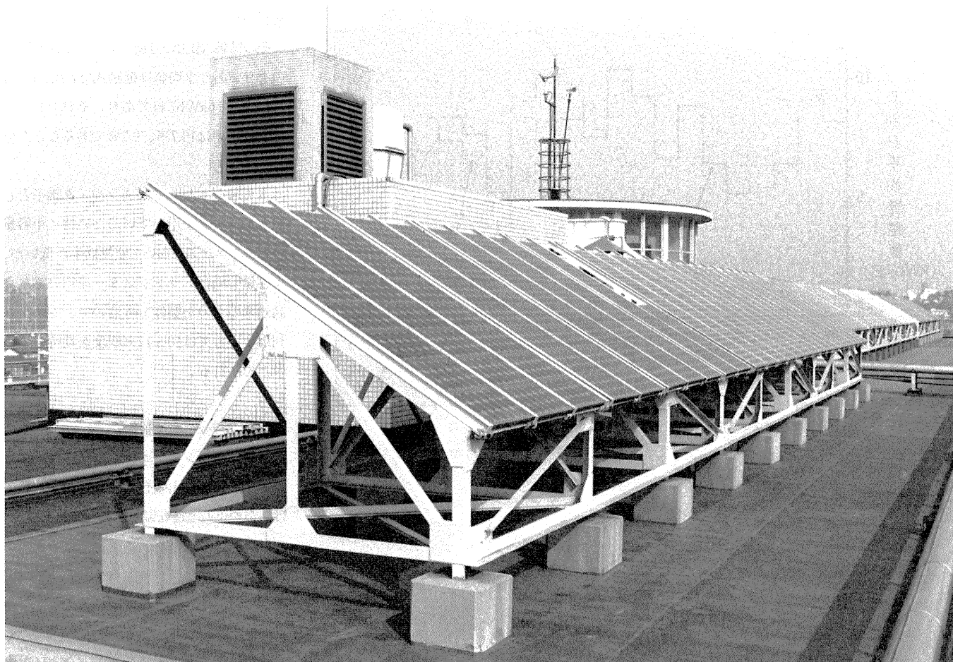
図2-3-4 6 kW太陽光発電実験設備 (3 kW × 2)
