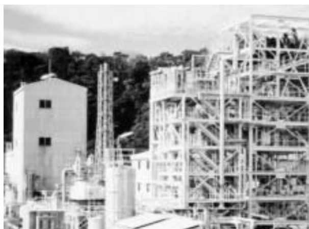
図4-1-1 2トン/日乾式集じん脱硫基礎実験装置
