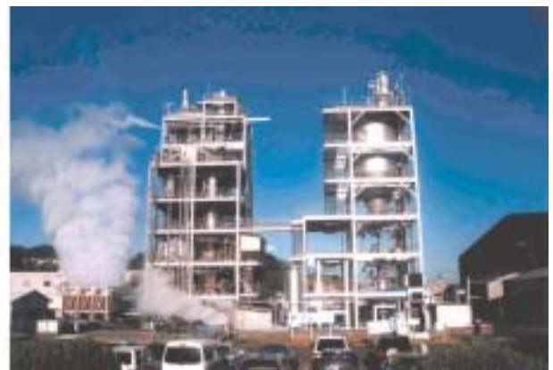
図2-1-2 24トン/日ガス化試験装置
