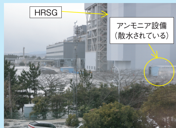
図1 津波にのまれるIGCC設備(アンモニア設備は自動で散水されている)
