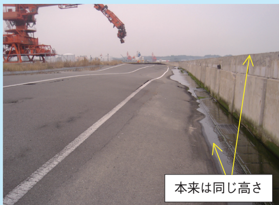
図2 小名浜港の揚炭機とバース（地面が陥没している）
