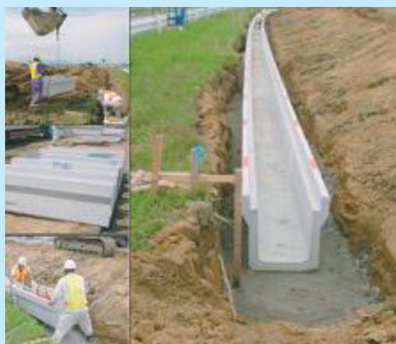
図3 コンクリート成型製品への利用<sup>(1)</sup>
