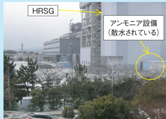
図1 津波にのまれるIGCC設備(アンモニア設備は自動で散水されている)
