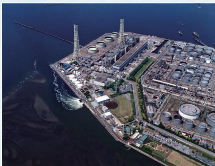
発電所から放水される温排水
