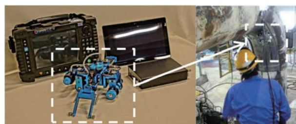
図4-6 フェーズドアレイ超音波非破壊検査装置による 実機配管の検査
